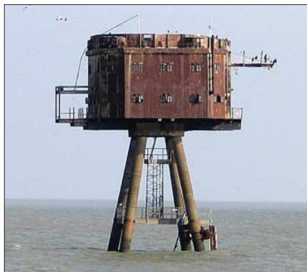
Aus diesem Turm senden Red Sands Radio und GBORSR. Zwischen den Betonstelzen ermöglicht ein Stahlgerüst den Zugang von See.
